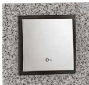
commande d'ouverture automatique des portes
